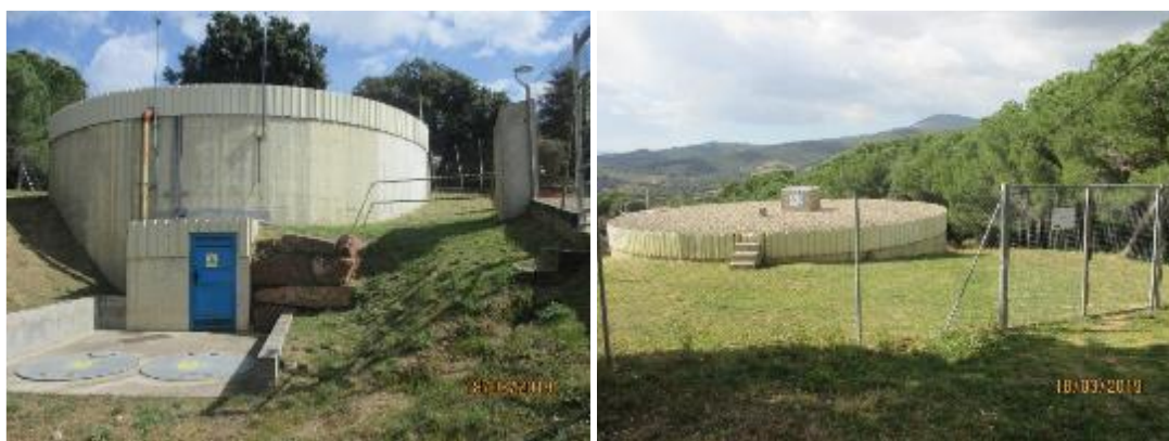
Figura 14. Dipòsit Can Poi 500
