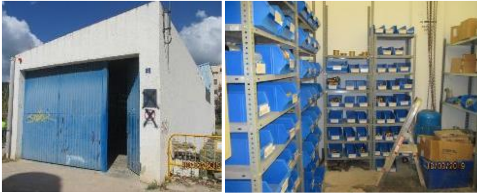
Figura 2. Pou Dyna i magatzem del servei. Exterior, bomba i zona emmagatzematge
