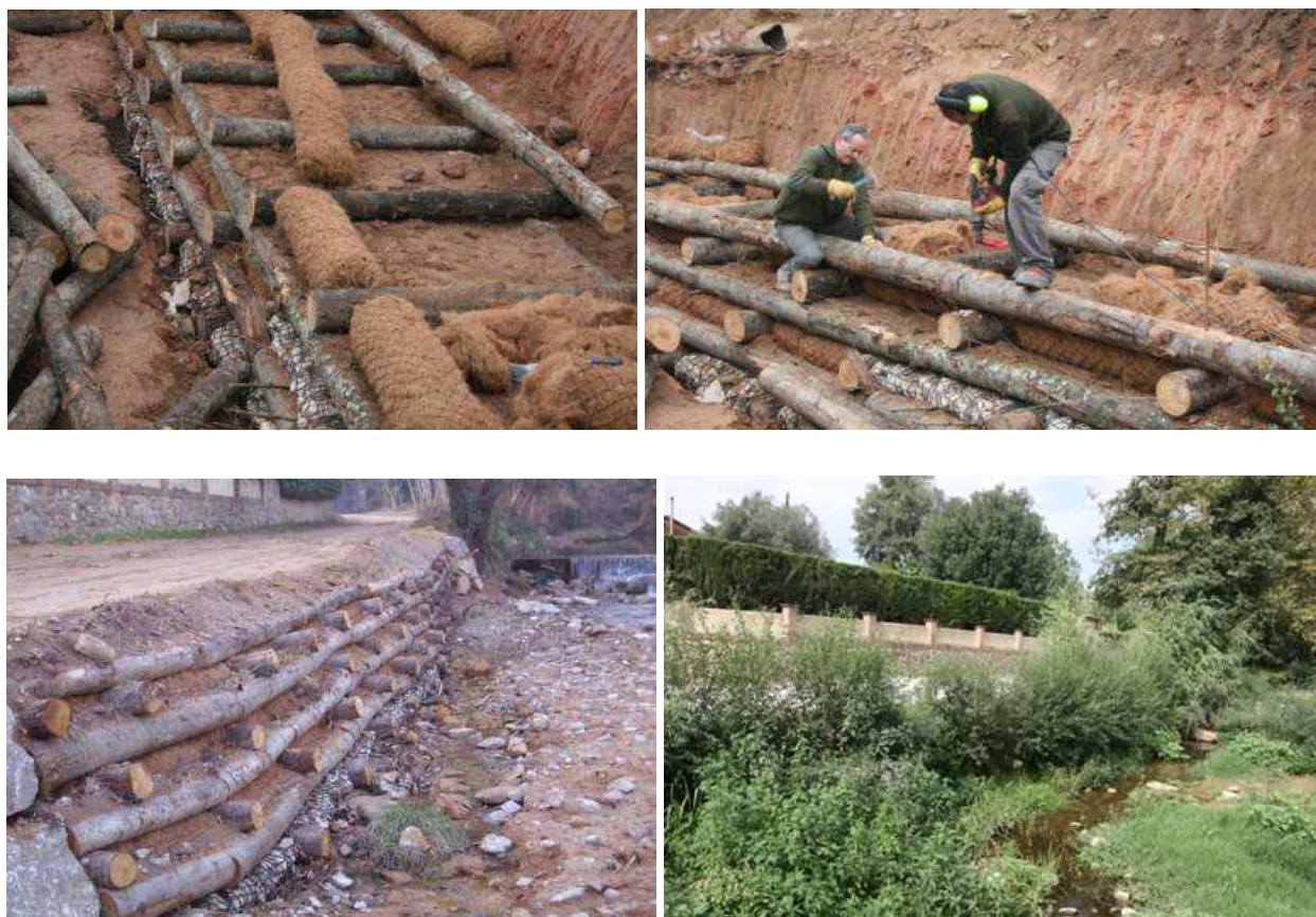
Imatges d'un entramat Krainer tipus Naturalea, procés constructiu i resultat final
