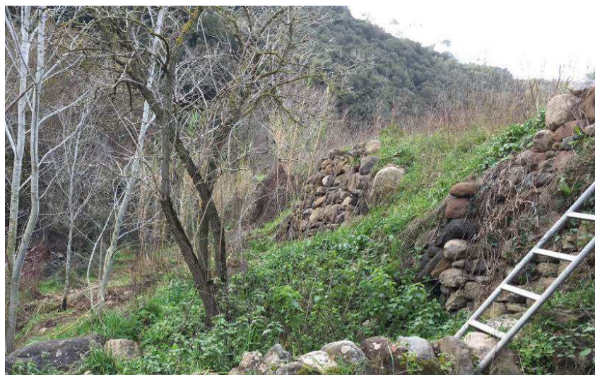
Vista del mur desmuntat
