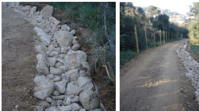
Exemple de cuneta de pedra
