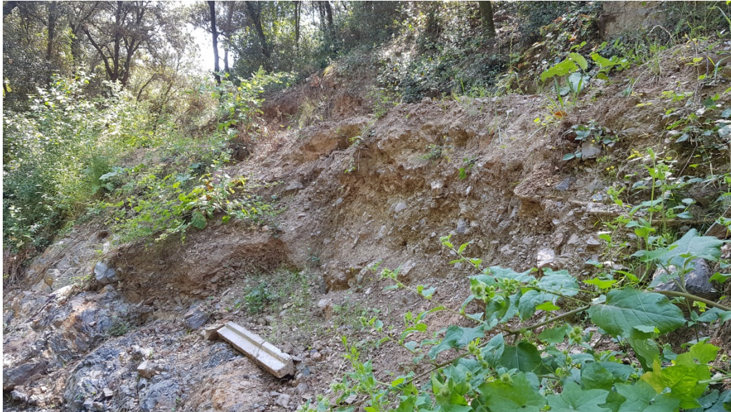
Imatge 8. Tram 1 Estabilització de marge
