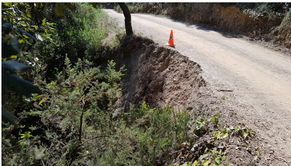
Imatge 2. Esllavissada del marge del torrent de Tremolencs que afecta el camí de Can Sunyer
