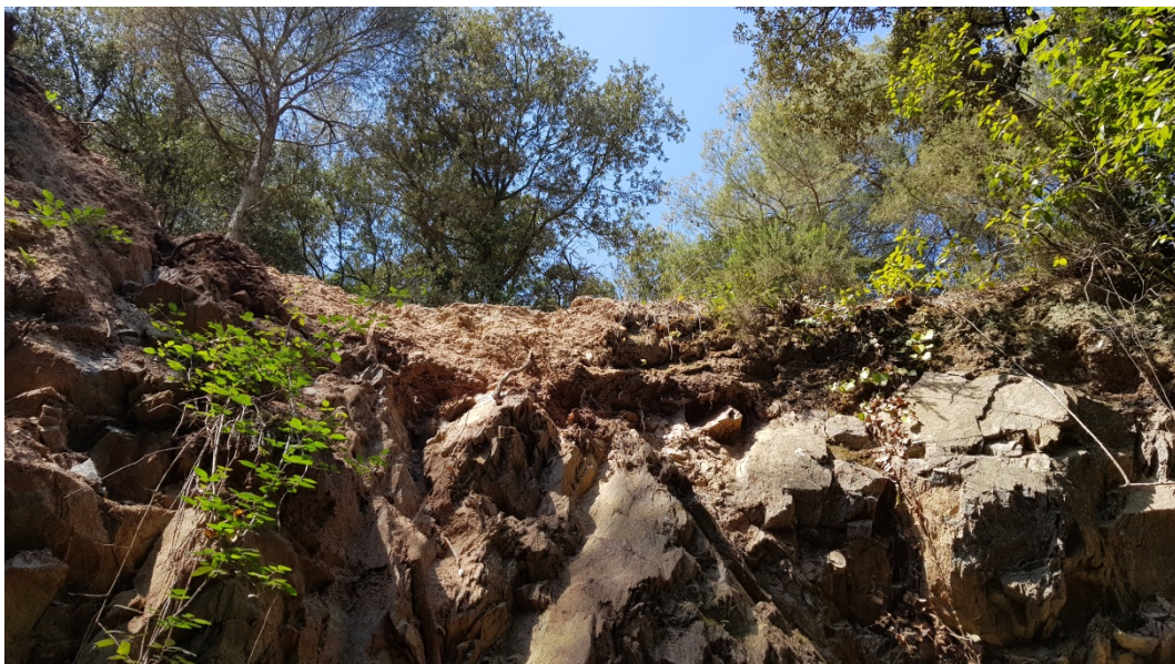
Imatge 9. Tram 2 Estabilització de marge
