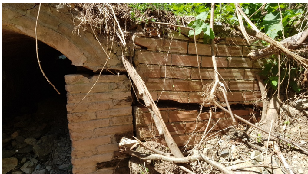
Imatge 3. Danys en els murs del pont sobre el torrent de Tremolencs
