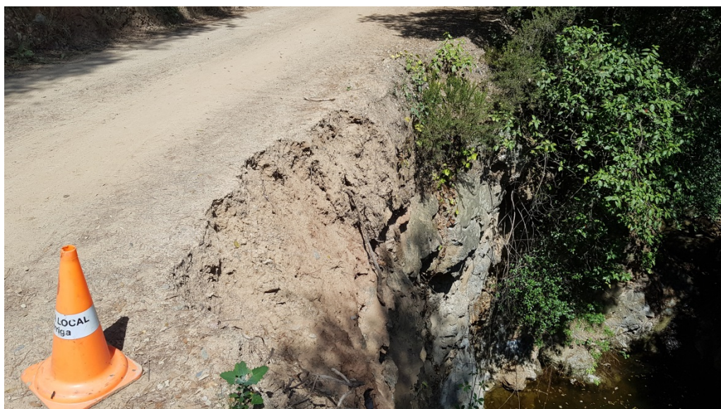
Imatge 3. Danys en els murs del pont sobre el torrent de Tremolencs
