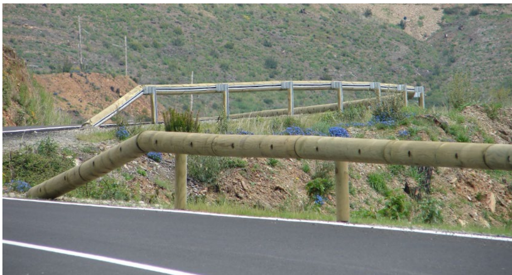
Imatge 17. Fotografia de la tipologia de barrera de seguretat mixta fusta-metall
