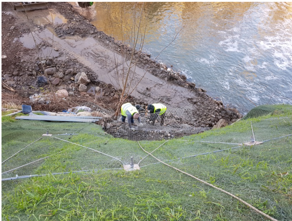
Imatge 12. Exemple de protecció de talús amb geomalla tridimensional de polipropilè i bulonat amb cables d'acer
