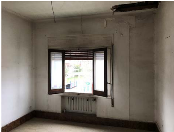
Foto 20. Habitació ctra. Nova contigua a escala. Finestra de 2 batents plegables. (4 fulles) / Dreta: finestra oval al vestíbul d'entrada des de la ctra. Nova.
