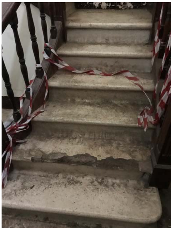
Foto 5. Escala amb esglaió malmès. / Dreta: porta de fusta del passadís en planta pis.
