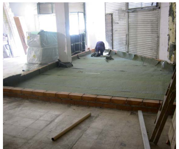
Montaje primera capa de A-1
