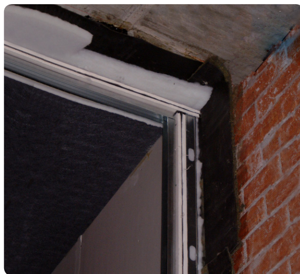
Trasdosado y techo aislante con LA.
