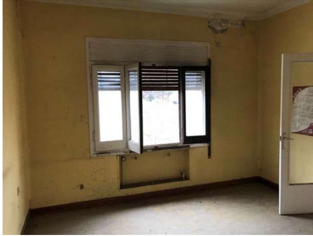
Foto 18 . Habitació ctra. Nova contigua a sala arcs. Finestra de 2 batents plegables. (4 fulles). Dreta: ampit
