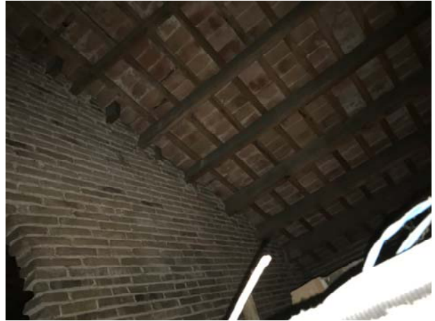
Foto 22. Nucli central de vestíbul d'escala amb paraments de fàbrica de maó massís fins a coberta, amb funció portant de coberta.
