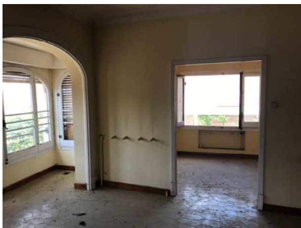
Foto 10. Habitació a la cantonada del pati d'accés / Dreta: obertura finestra amb portes batents i plegables de fusta.
