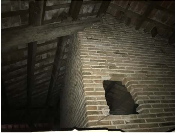
Foto 22. Nucli central de vestíbul d'escala amb paraments de fàbrica de maó massís fins a coberta, amb funció portant de coberta.
