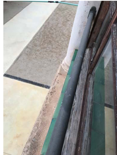
Foto 14. Tribuna o galeria pati. Finestra lateral esquerra. / Dreta: barana ancorada a pilarets exteriors.
