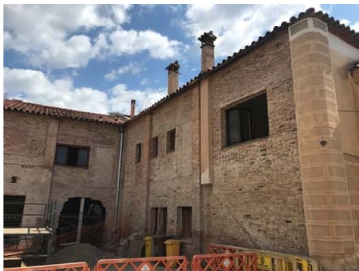
Façana del pati interior (orientació oest).
