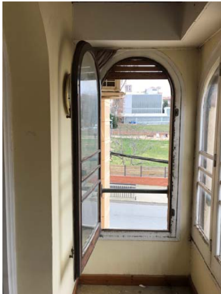
Foto 14. Tribuna o galeria pati. Finestra lateral esquerra. / Dreta: barana ancorada a pilarets exteriors.
