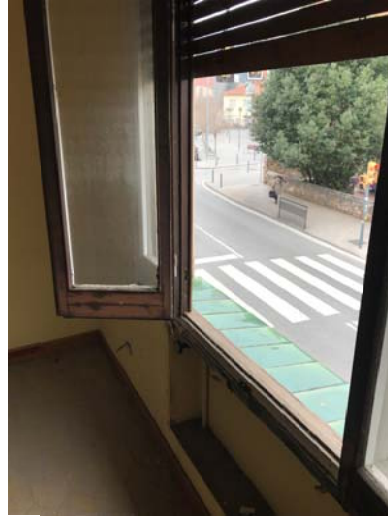
Foto 18 . Habitació ctra. Nova contigua a sala arcs. Finestra de 2 batents plegables. (4 fulles). Dreta: ampit
