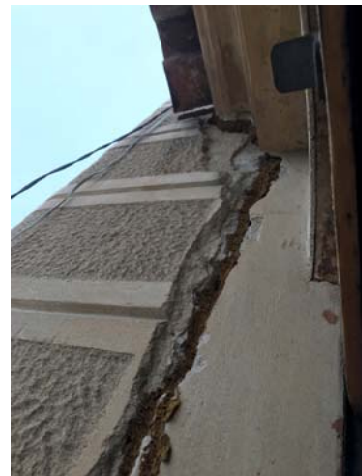
Foto 17. Tribuna o galeria ctra. Nova. Finestra lateral esquerra (entrada línia telefonia (PTR)). / Dreta: Dreta: fissura a la façana.
