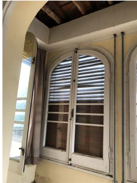
Foto 15 .Obertura amb arc el·líptic d'accés a la galeria de la ctra. Nova / Dreta: obertura lateral dreta
