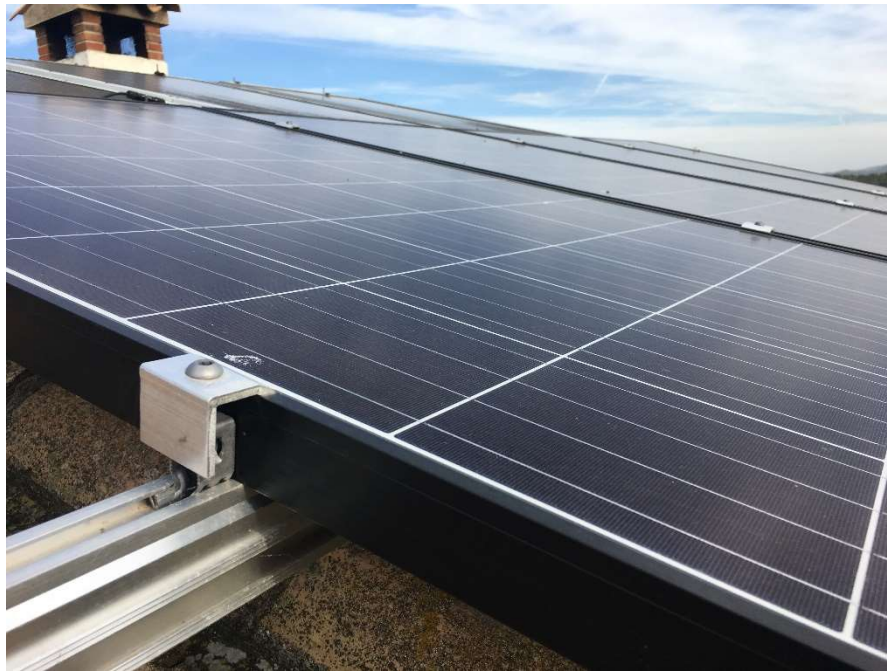
Figura 9: Detall estructura de fixació al
