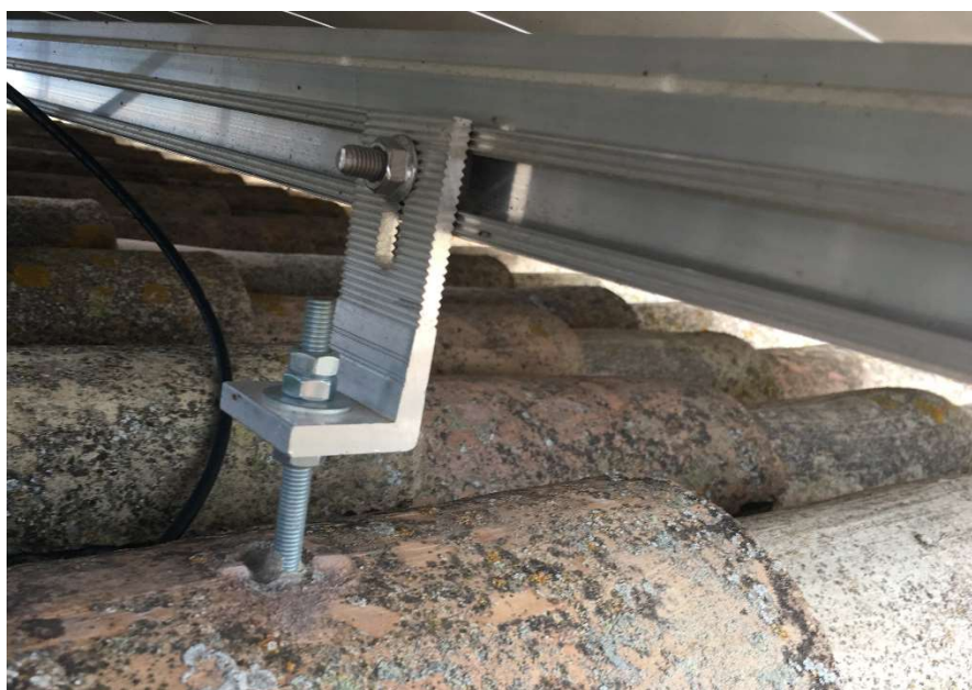
Figura 8: Detall estructura de fixació
