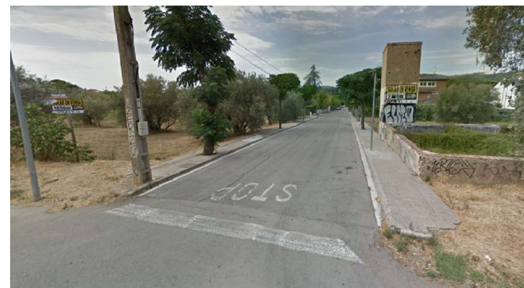
IMATGE ESTAT ACTUAL C/ CAST OLIVER
